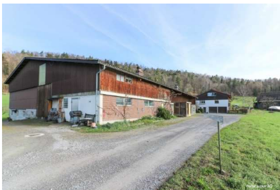
Ökonomiegebäude Vers. Nr. 1643, Wohnhaus Vers. Nr. 1642, Wagenschopf Vers. Nr. 352 Westansicht
