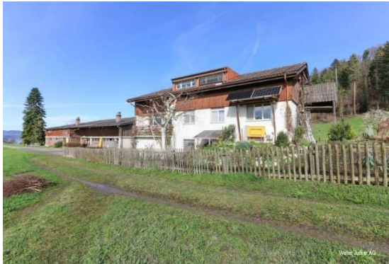
Wohnhaus Vers. 1642 und Ökonomiegebäude, Vers. Nr. 1643 Südostansicht
