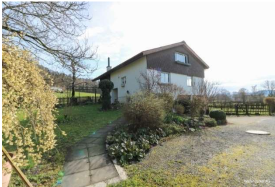
Wohnhaus Vers. 1642, Nordwestansicht
