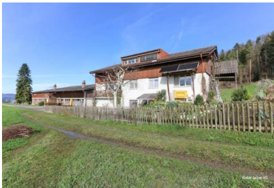
Wohnhaus und Ökonomiegebäude, Westansicht
